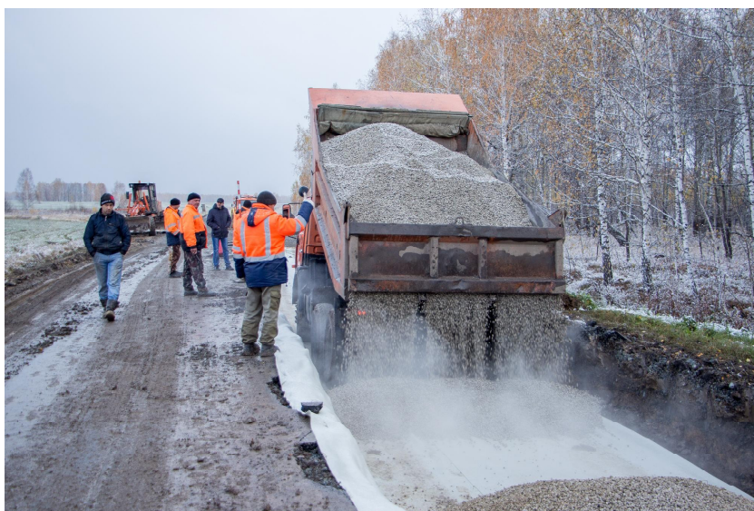
Рис. 6. Процесс укладки теплоизоляционного слоя из ГПСК в одну из секций участка автомобильной дороги / Fig. 6. The process of laying insulation layer GPSK in one of the sections of the road section
